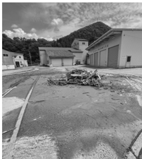
泥やがれき等が堆積した今庄支店の様子
